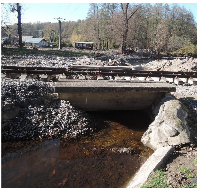
Obrázek 2. Pohled zprava na stávající propustek
